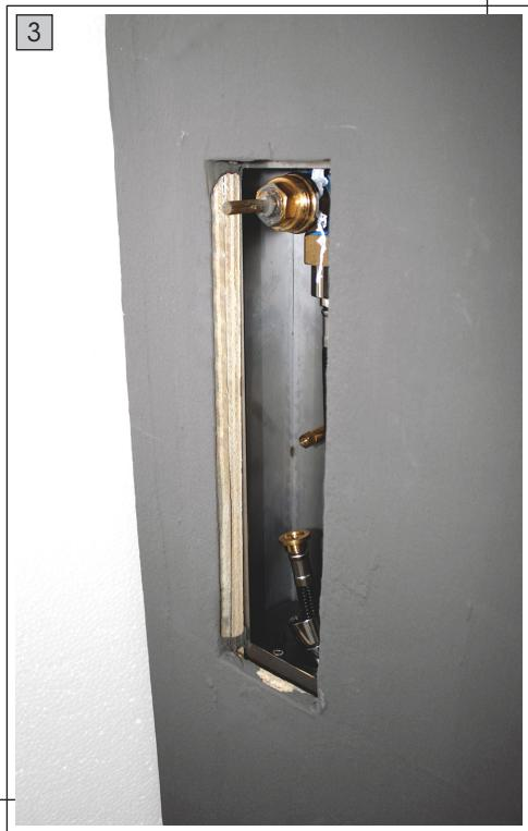
ALLINEAMENTO MANIGLIA\_HANDLE ADJUSTING\_ALIGNEMENT POIGNÉE\_AUSRICHTUNG DES HEBELS\_ محاذاة المقابض
